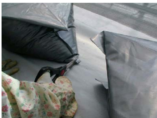
写真13 排水孔の作成
