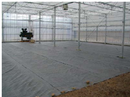
写真2 下敷シート設置後
