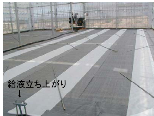
写真3 防根シート設置後
